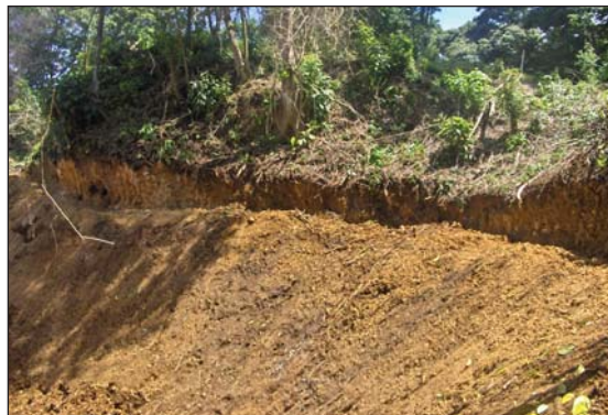
El control de lixiviados incluye también interceptar aguas superficiales cercanas al relleno o vertedero controlado.
