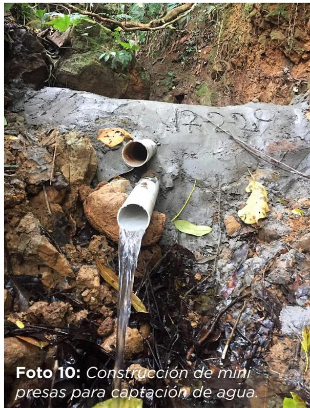
**Foto 10:** Construcción de mini presas para captación de agua.
